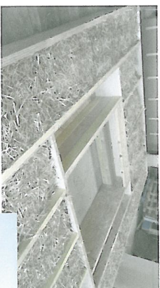
Construction en atelier des murs préfabriqués
